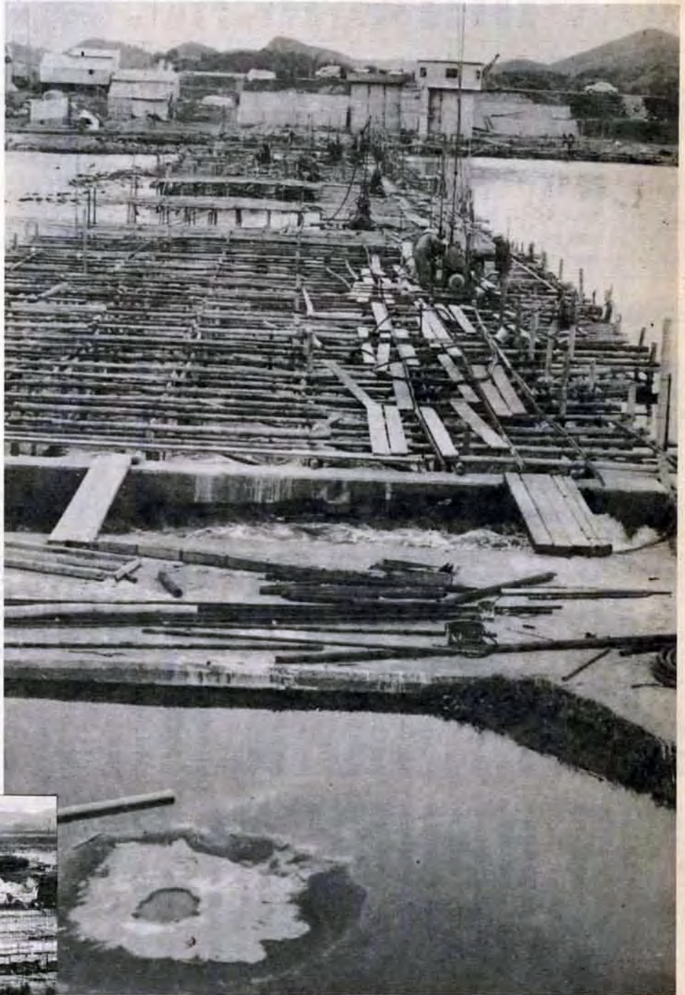
拡張工事がすすむ取水場（写真左）と改修中の取水せき（写真上）
