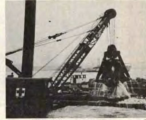
国際船路のしゅんせつ作業
