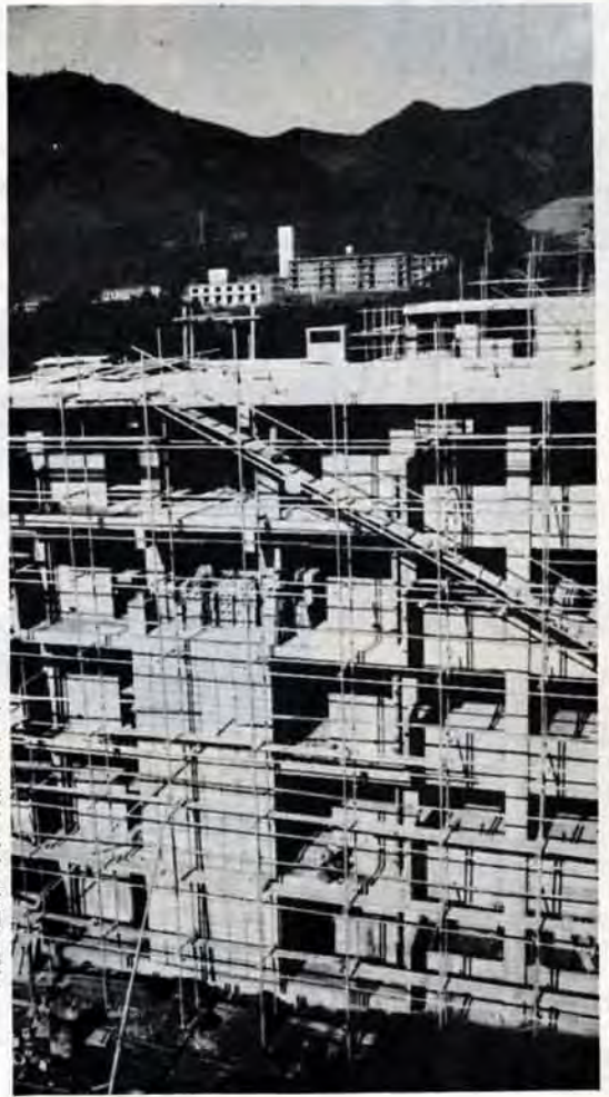
市営住宅の建設（小倉区吉田団地で）
