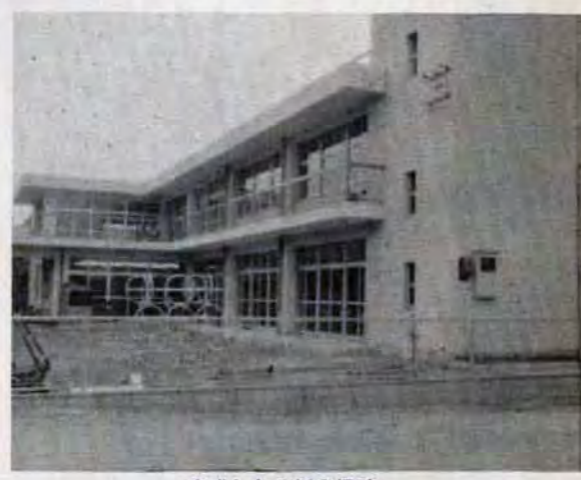
完成した八幡乳児院
