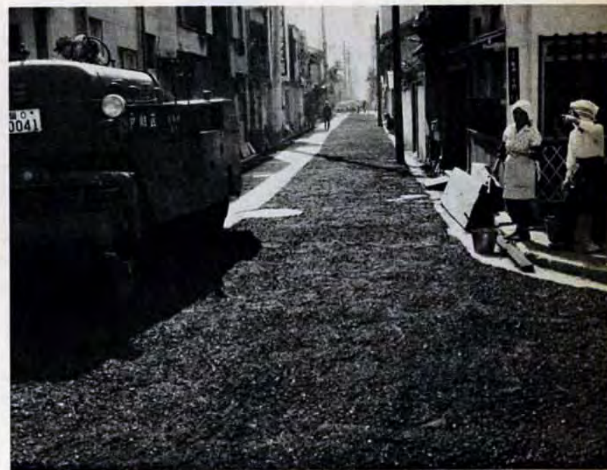
舗装がすすむ町づくり道路。ことしは、139キロメートルを舗装
