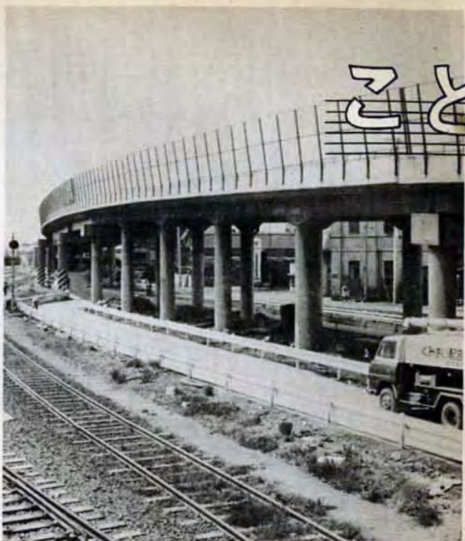
完成も近い、国道199号線の門司区小森江の高架部分
