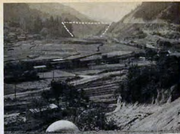
↑道路工事がすすむ油木ダム
