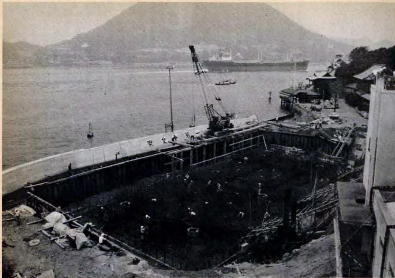
門司側の橋脚基礎工事。総重量2万8,000トンの鋼材でできる橋を、2基ずつの橋台と塔で支える。その足、の1つがここ。巨大なコンクリートのかたまりが大地にこみ込ます(右上はめかり神社。対岸は下関の火ノ山)
