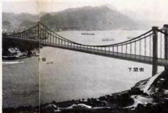
48年には、東洋一の橋が海峡をまたぎます
