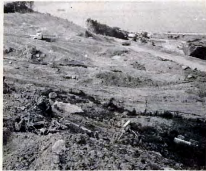
整地が始まっためかり公園第一展望台。ここにメインケーブルを固定する橋台ができます(右上はふもとのめかり塩水プール)
