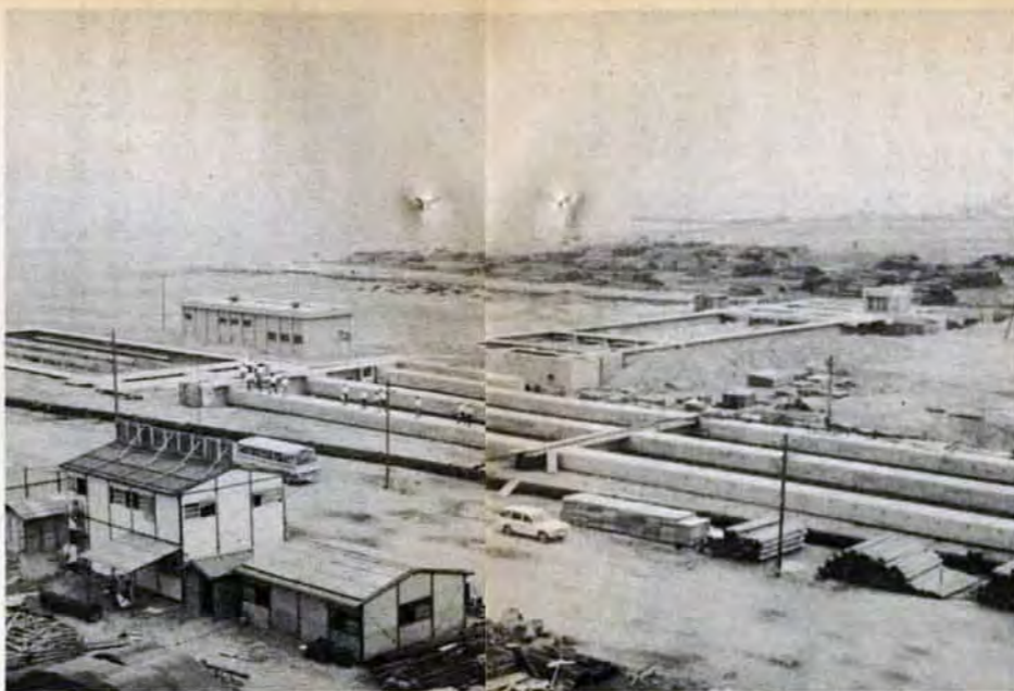
日明下水処理場…小倉区日明臨海工業用土、西日本一を誇るマンモス処理場が建設されています。来年の春にはまず戸畑区の7割分の水洗化が可能になります。将来は戸畑区と小倉区、八幡区の一部を受け持つ施設(3万6千人分)となります。
