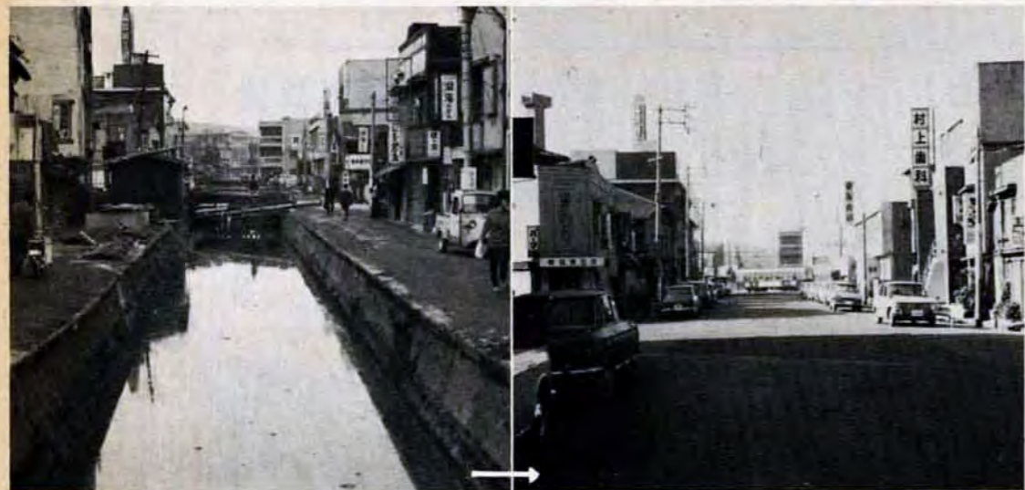
異臭を放つドブ川が町を貫いていたが(左の写真)幹線下水道の敷設できれいな道路に生まれ変わり、町(右の写真)は一変<八幡区黒崎町>
