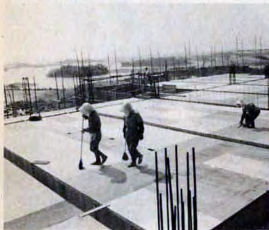
↓一階の天井に張られたベニヤ板がチェス盤のように見える
