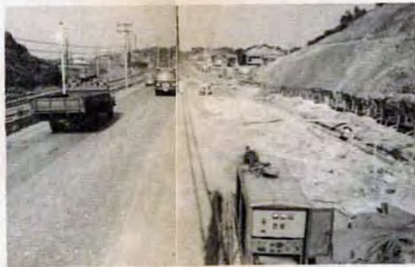
国道一九九号線、若松区二島付近の拡幅工事。
