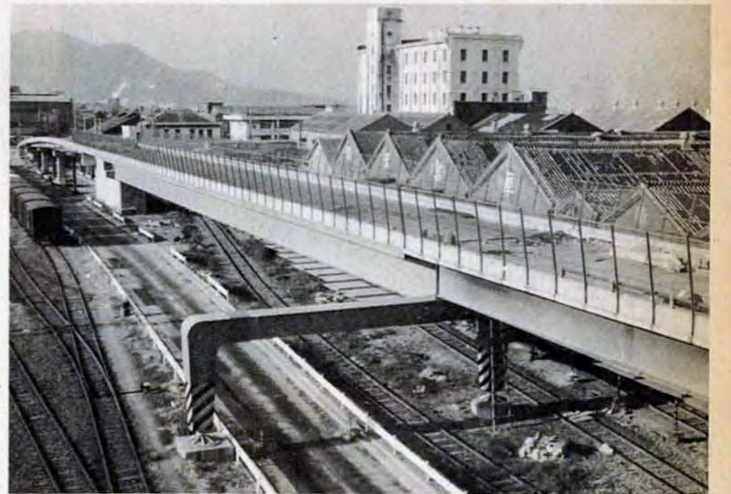
国道199号線 小森江高架部 国道199号線の中でも最も難工事といわれた全長659m、幅員7.5mの高架道路が、門司区小森江に完成。道路の下には工場への側道もできています。
