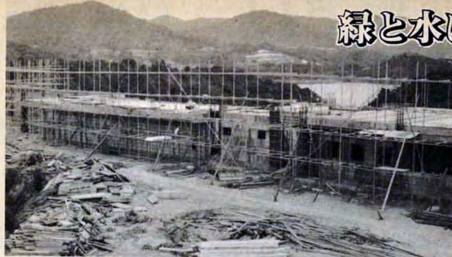
↑一階部分の外壁はほとんどできあがり、コンクリートの流し込みを待つばかりです
