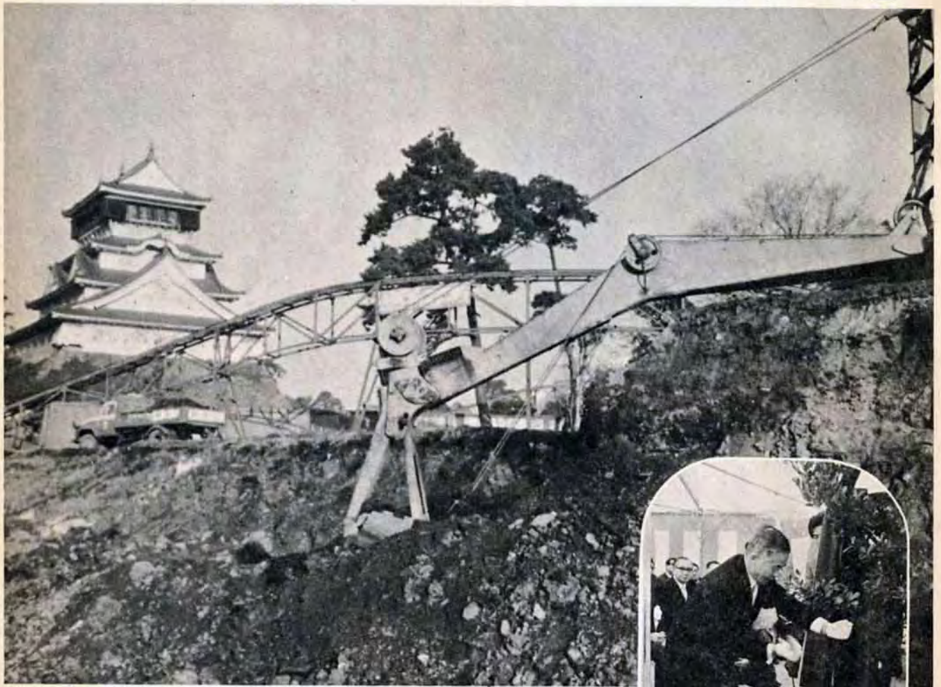
地下15mを掘り下げる基礎工事。写真右は1月13日の起工式でカマをふるう谷市長
