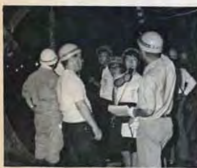
取材中の勝山幹線工事現場
