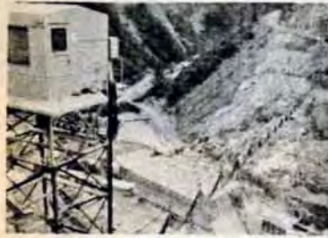
建設中の「ます淵ダム」
