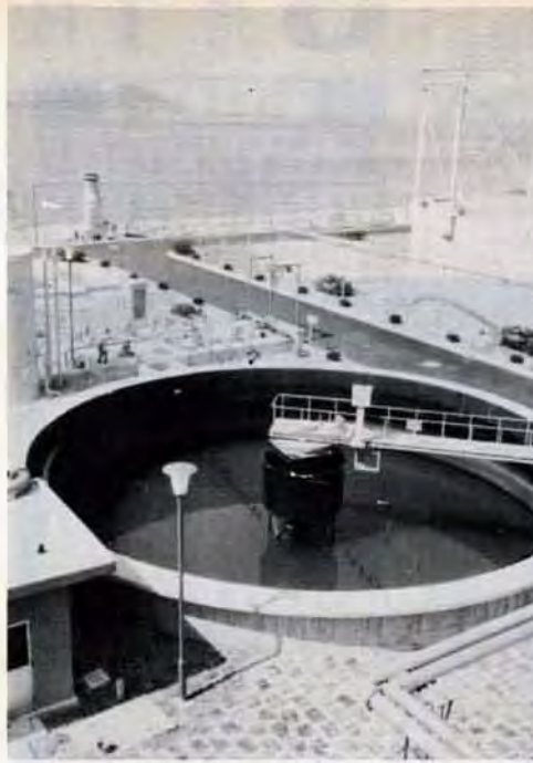
新町下水処理場
