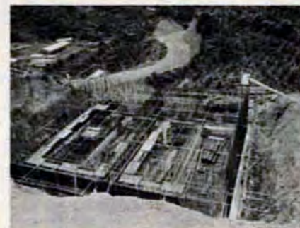
高台に建設される高蔵高区配水池(小倉南区)
