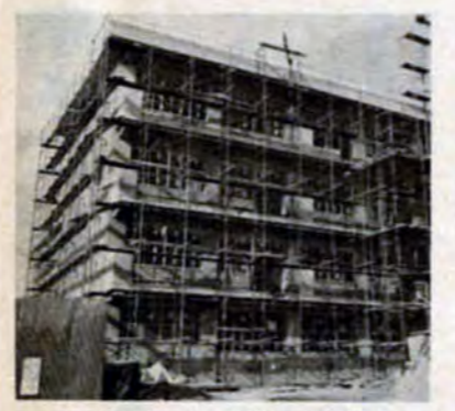
建設急ピッチ・第2塔野小学校
