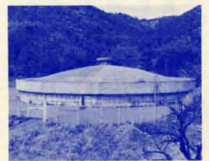
井手浦高区配水池
