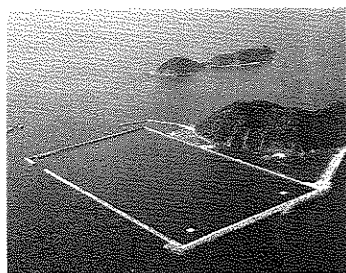
▲白島石油備蓄基地=平成8年供用開始予定で、1隻70万klの貯蔵船8隻を浮かべます。
