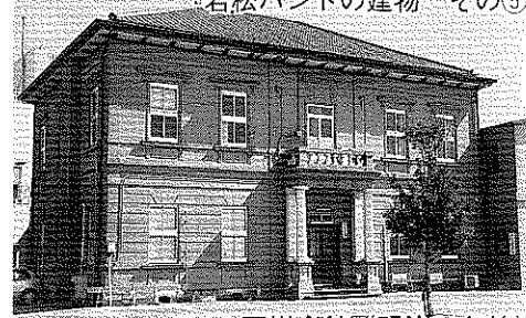
石炭会館(明治38年築)
