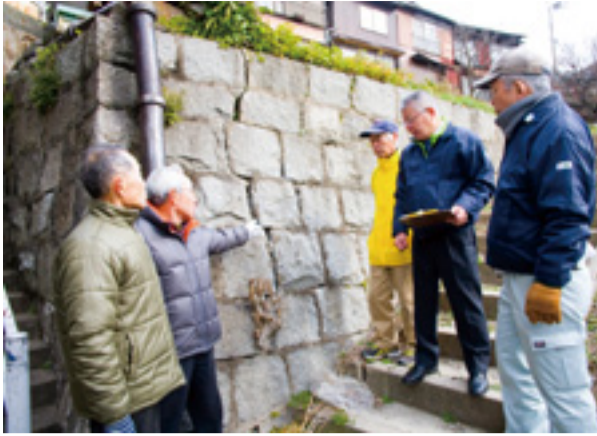
▲ひびの入った擁壁もチェック
