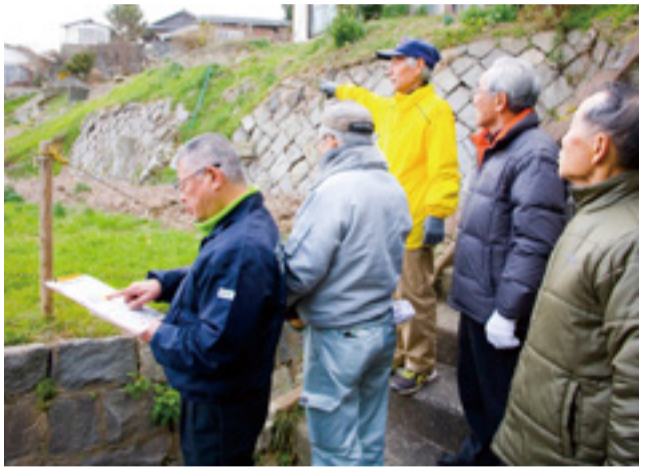
▲昨年7月の崖崩れ発生箇所
