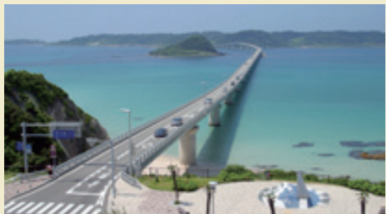
▲角島大橋(下関市)
