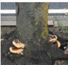
▲キノコによる腐食
