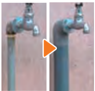
▲保温チューブの取り付け
