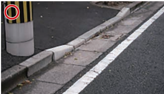
歩道切り下げ工事施工後
