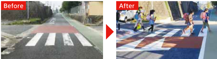
▲横断歩道部分が路面より10cm盛り上がり、車が減速する「スムーズ横断歩道」
