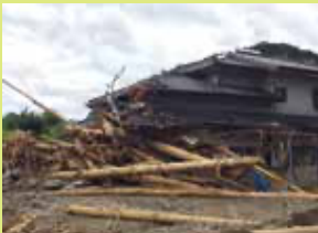
▲平成29年7月九州北部豪雨 で被災した家屋
