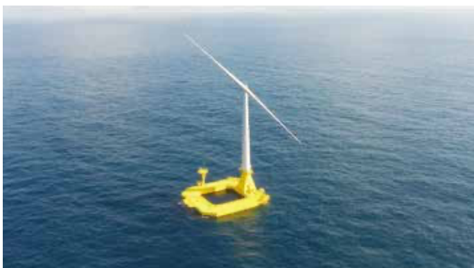
▲浮体式洋上風車 提供:NEDO
