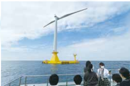
洋上風力発電施設
