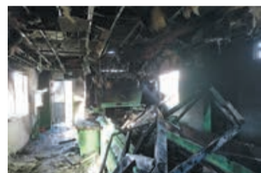
▲リチウム電池の発火が原因で起きた火災の例 出典:(公財)日本容器包装リサイクル協会
