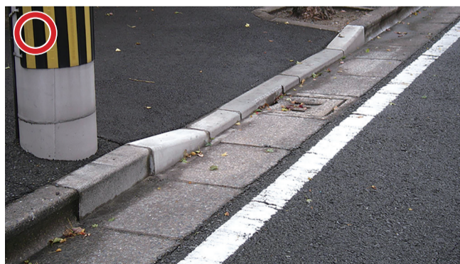
歩道切り下げ工事施工後
