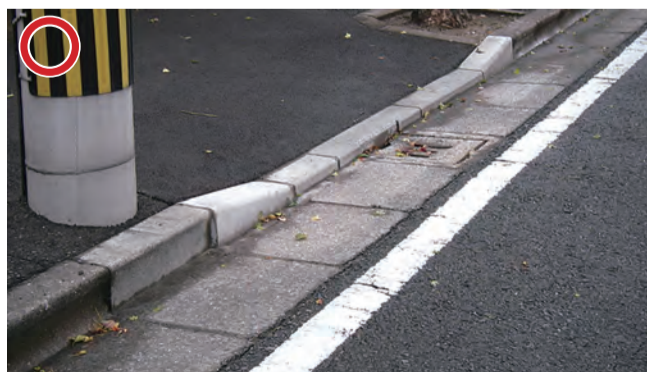
歩道切り下げ工事施工後
