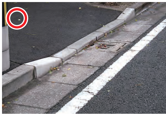
▲歩道切り下げ工事施工後
