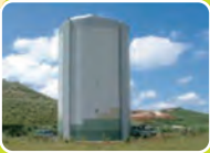
▲平尾台配水池
