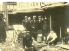
▲水道創設時の給水管布設(門司市)
