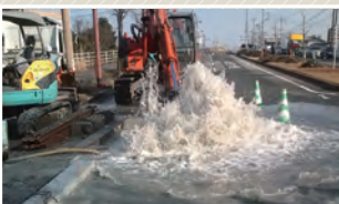
▲水道管の老朽化による漏水
