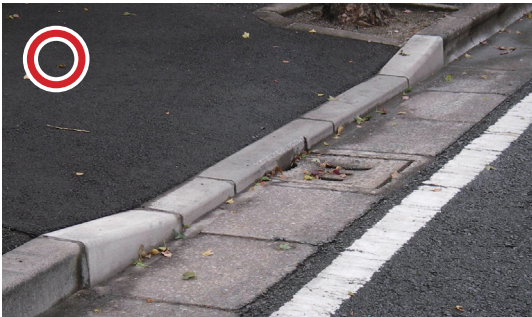
▲歩道切り下げ工事施工後
