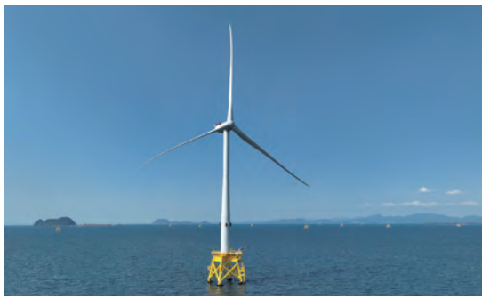
▲建設中の洋上ウインドファーム
