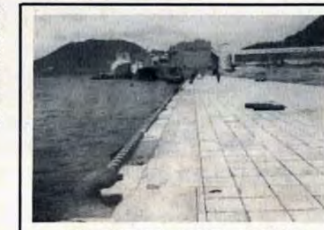
【門司港に完成した外浜の12号岸壁】
