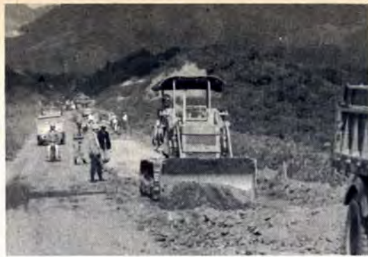
市民の要望にこたえ急ピッチの道路改修工事
