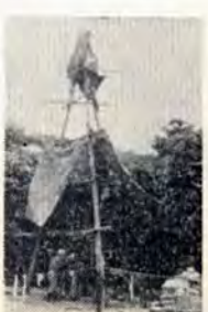
(ボーリング調査)
