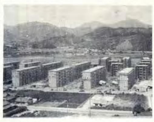
日本住宅公団が、22万7000平方メートルの土地に、44年度までに鉄筋アパート88とう(2400戸)の住宅を建てます。
