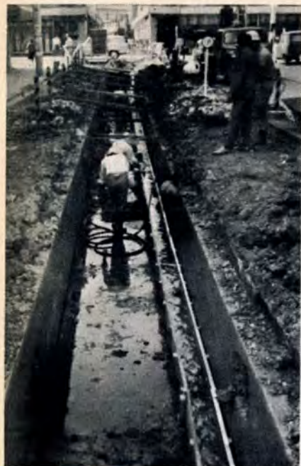
下水工事(戸畑区宮通)
