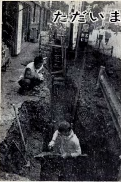
幸町電停付近の下水道工事
