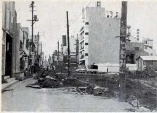
小倉駅前駐車場混雑をゆるめるために 小倉駅前周辺には、ビルが建て込んで駐車場の設置が望まれ、市でも検討をすすめています。とりあえず少しでも緩和できればと、同駅前から東に向いて走る道路・博労町線を、41年度中に現在の6m幅を15m幅に、のべ164mにわたって、拡幅工事をすすめています。舗装は42年度に行なうことにしています。
