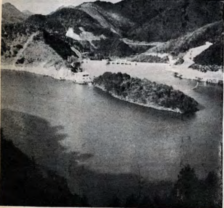
力丸ダム このダムを主体とする第2期拡張工事で、63億円の資金が必要と見込まれ、そのうち70年までの和金の2.2倍の136億円が不足する見込みです。
