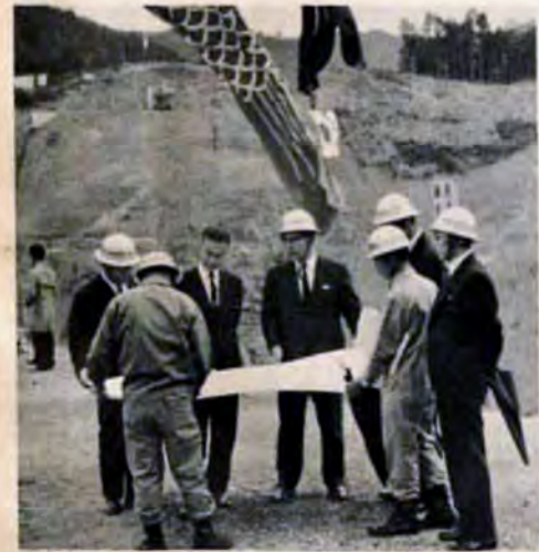
油木ダム 英彦山麓から本市へ1日10万6千トンの水を引く油木ダムは、6月ダム本体の工事に着手しました。
