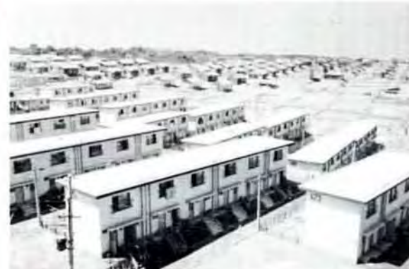
市営住宅1万5千戸に 44年度の1,429戸を加えると計1万5千戸を突破します。(八幡区小嶺で、後方は分譲住宅)
