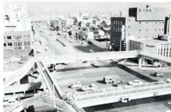
交通戦争に備える 44年度は、歩道橋10基の建設、歩道17キロ新設、照明灯82灯設置など新3か年計画の初年度で3億円を使いました。
