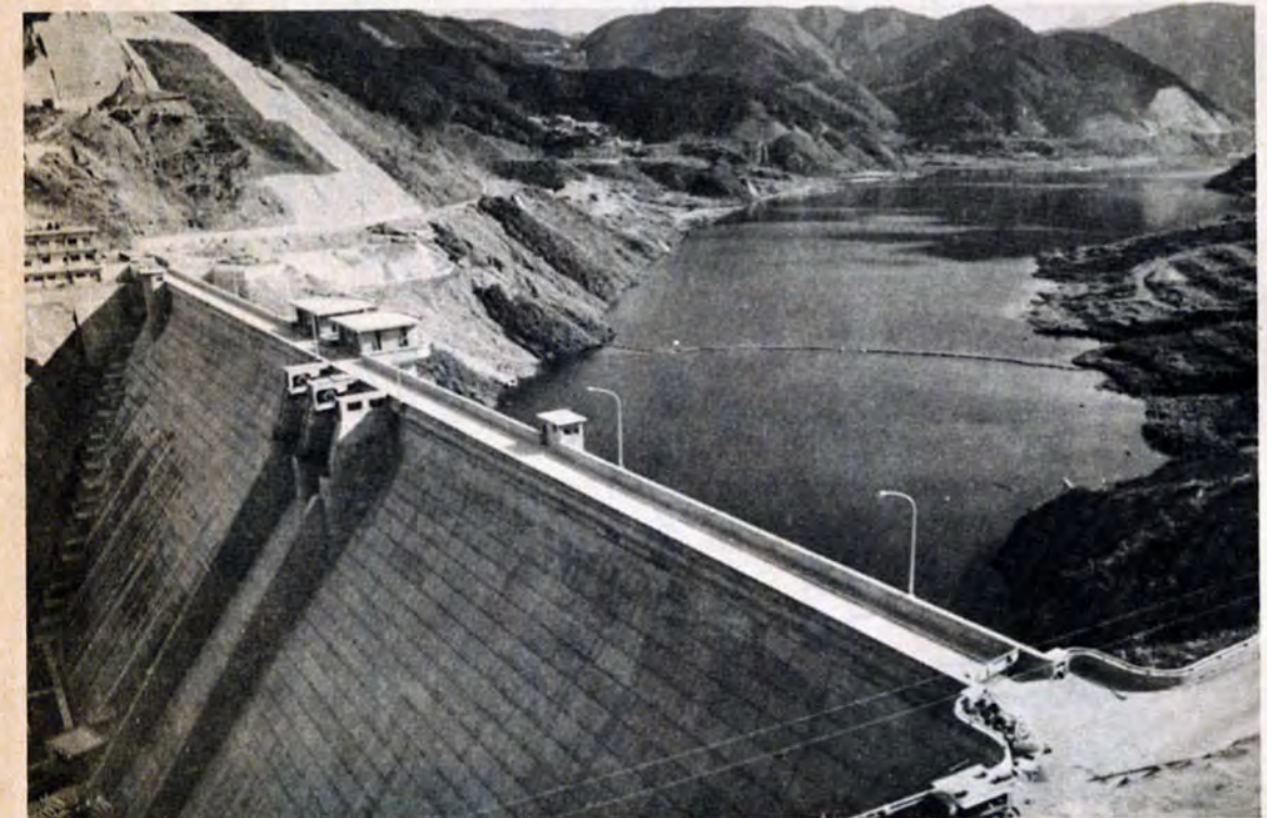
油木ダムが完成し、水不足が解消されます。来年夏には、1日10万6千トンの水が27キロのトンネルを通過して北九州市へ送られてきます。
