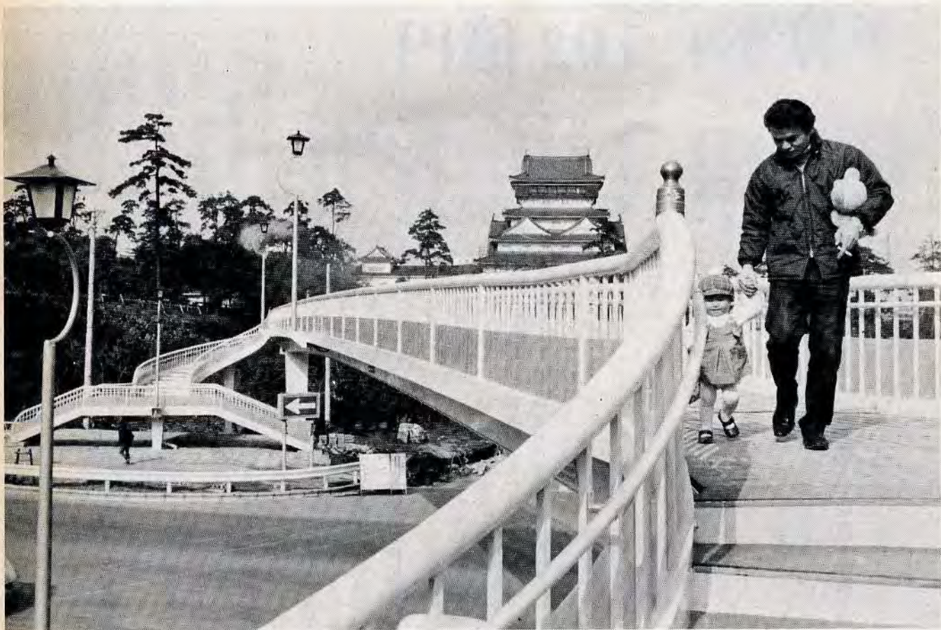
2月23日完成した「城見歩道橋」。
