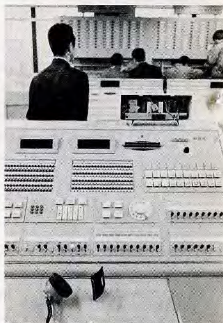
消防指令センター 2月16日、機械を運び入れ、さっそく調整にとりかかっています
