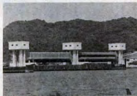
もっと水がめを——建設の進む遠賀川河口堰
