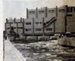
新々堀川排水機場通水（6月）
