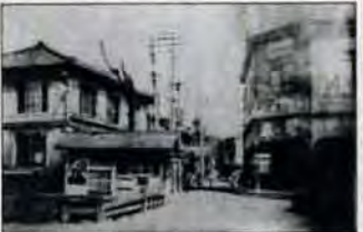
大正5年、共進亭と電車駅舎
