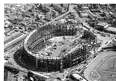
▲建設中のメディアアドーム
