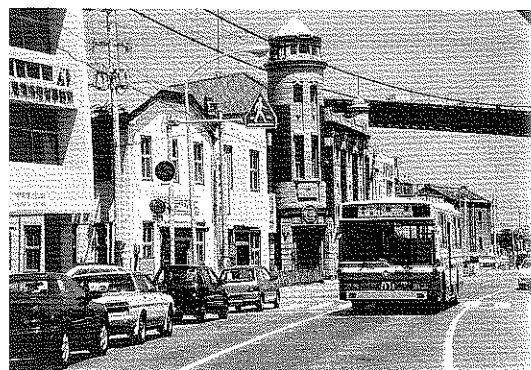
▲本町一丁目(旧南海岸通り)附近。尖塔の建物が「旧古河鋳業ビル」。
