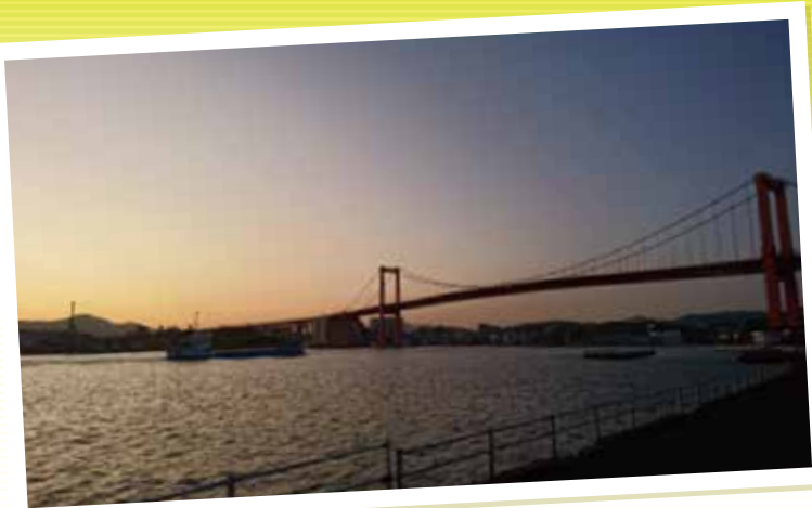
若戸大橋 所在地:若松区~戸畑区間
